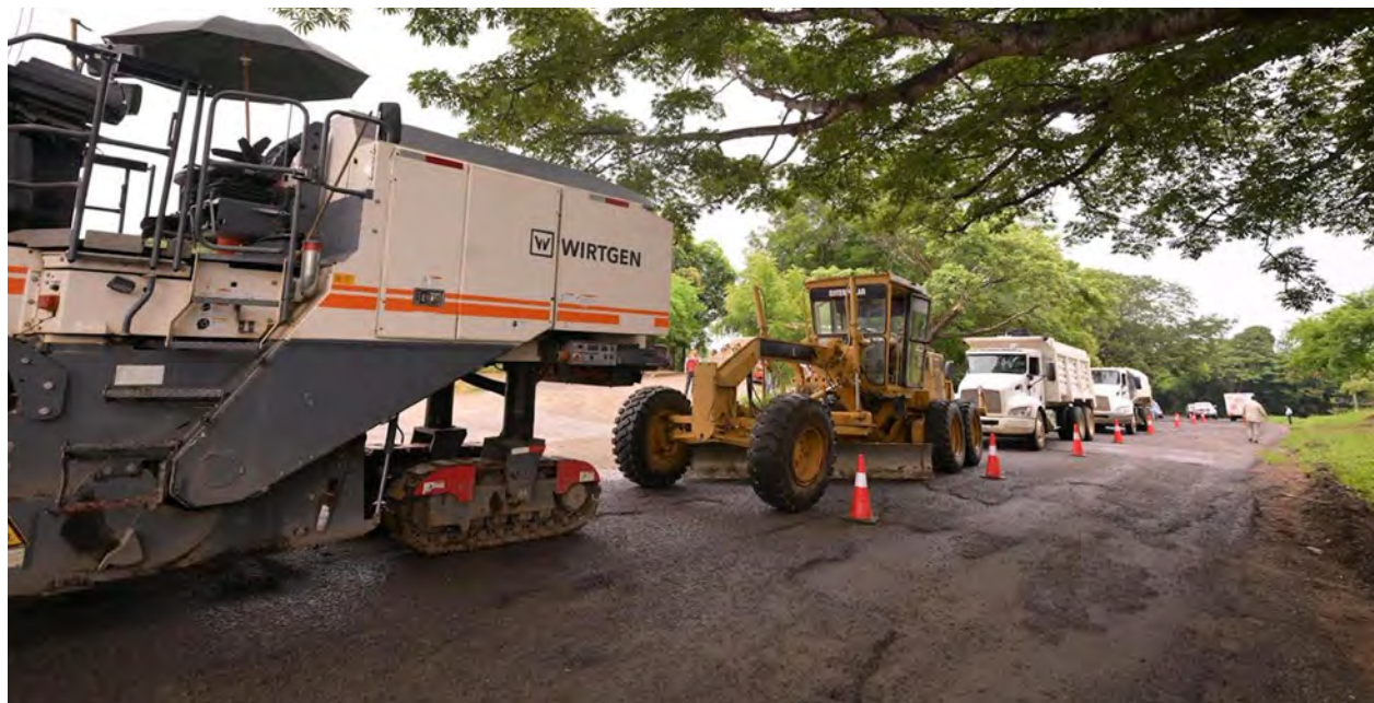
FOTOGRAFÍA 33 Rehabilitación del tramo carretero El Paralelo-Las Choapas, Veracruz. 3 de agosto de 2025. Fotografía del Gobierno del Estado de Veracruz.
