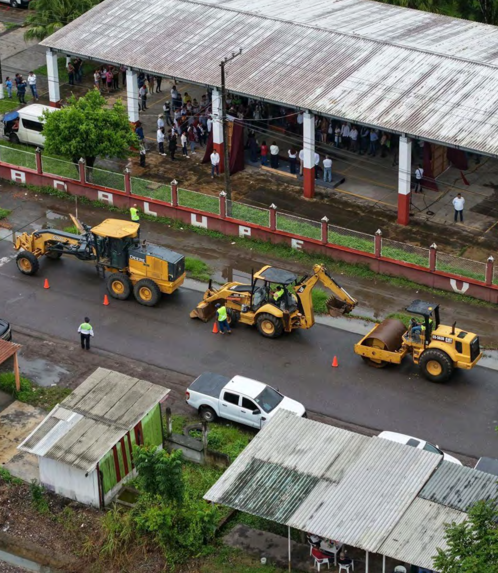
FOTOGRAFÍA 32 Rehabilitación del Tramo Carretero Motzorongo-Tezonapa. 22 de octubre de 2025. Fotografía del Gobierno del Estado de Veracruz.
