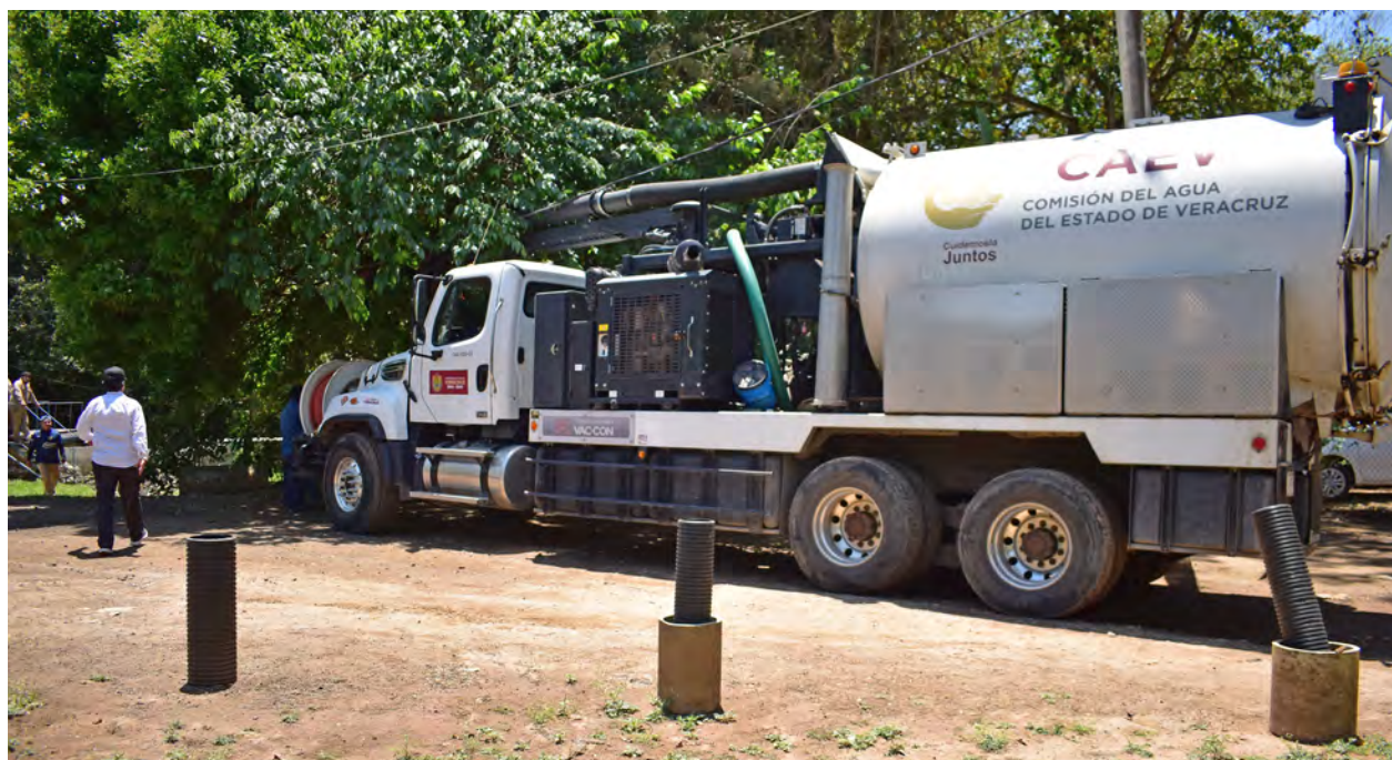
FOTOGRAFÍA 35 Limpieza y desazolve de manantiales en El Castillo, Xalapa Veracruz. 10 de abril de 2025. Fotografía del Gobierno del Estado de Veracruz.
